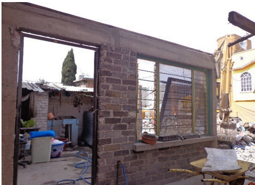
Etapa de limpieza de escombros y demolición. Pueblo de San Gregorio Atlapulco, Delegación Xochimilco. Enero de 2018. Foto de María Asunción Avendaño, coordinadora de brigada de Geografía-UNAM
