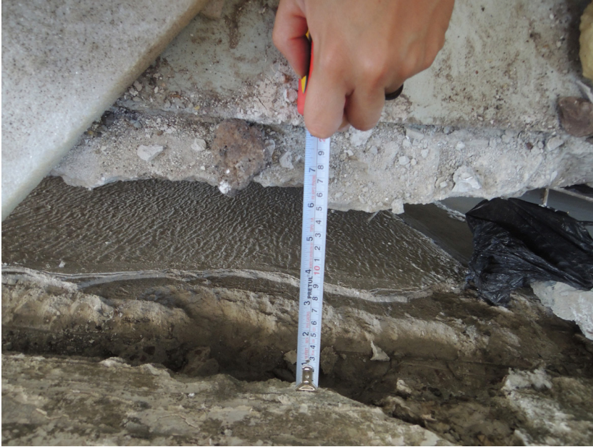
Profundidad de una grieta. Colonia Villa Centroamericana, Delegación Tláhuac. Noviembre de 2017. Foto de Eva Bidegain, brigadista de CIESAS
