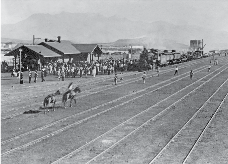
Estación de ferrocarril, Cuartel General de los constitucionalistas, panorámica. SINAFO-Archivo Casasola.
