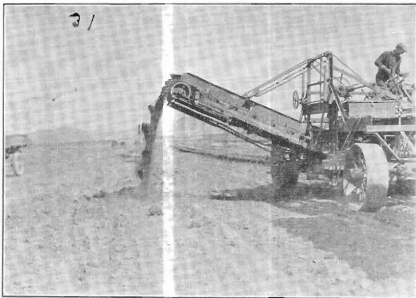
Caminos.—Equipo.—Conformadora Elevadora Western.
