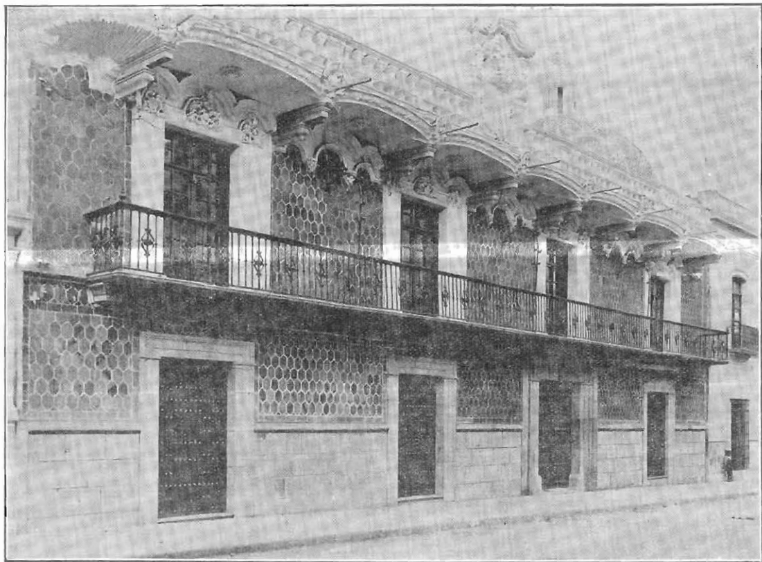
Casa núm. 8 de la calle de Raboso, Puebla.—Fachada después de la reparación.
