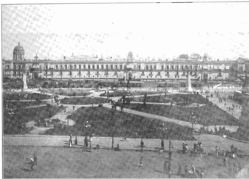
El Palacio Nacional antes de efectuarse las obras.
