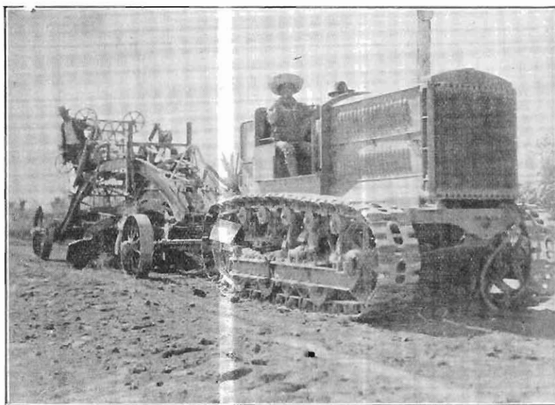
Caminos.—Equipo.—Tractor Holt y Conformadora Austin.
