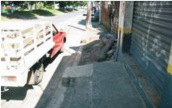
Figura 9. Falta de tramos de banqueta y otros obstáculos para el peatón.
