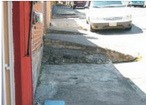
Figura 5. Rampa para acceso de un vehículo que obstaculiza el paso sobre la banqueta.
