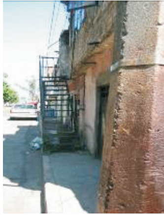
Figura 10. Escaleras metálica y de concreto instaladas sobre una banqueta.
