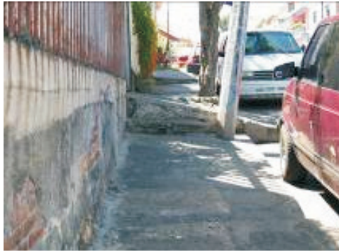
Figura 4. Rampa para automóvil que estorba el paso sobre la banqueta.
