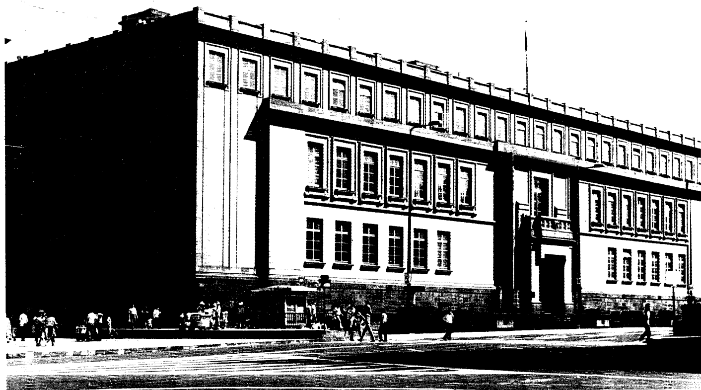
83 Fachada principal del Edificio sede de la Suprema Corte de Justicia, que ve hacia el poniente.
