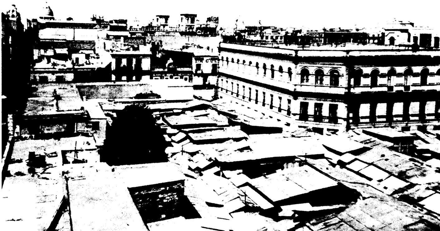
77 Vista Panorámica de la esquina suroriental del edificio, rodeado de puestos de ínfima categoría.
