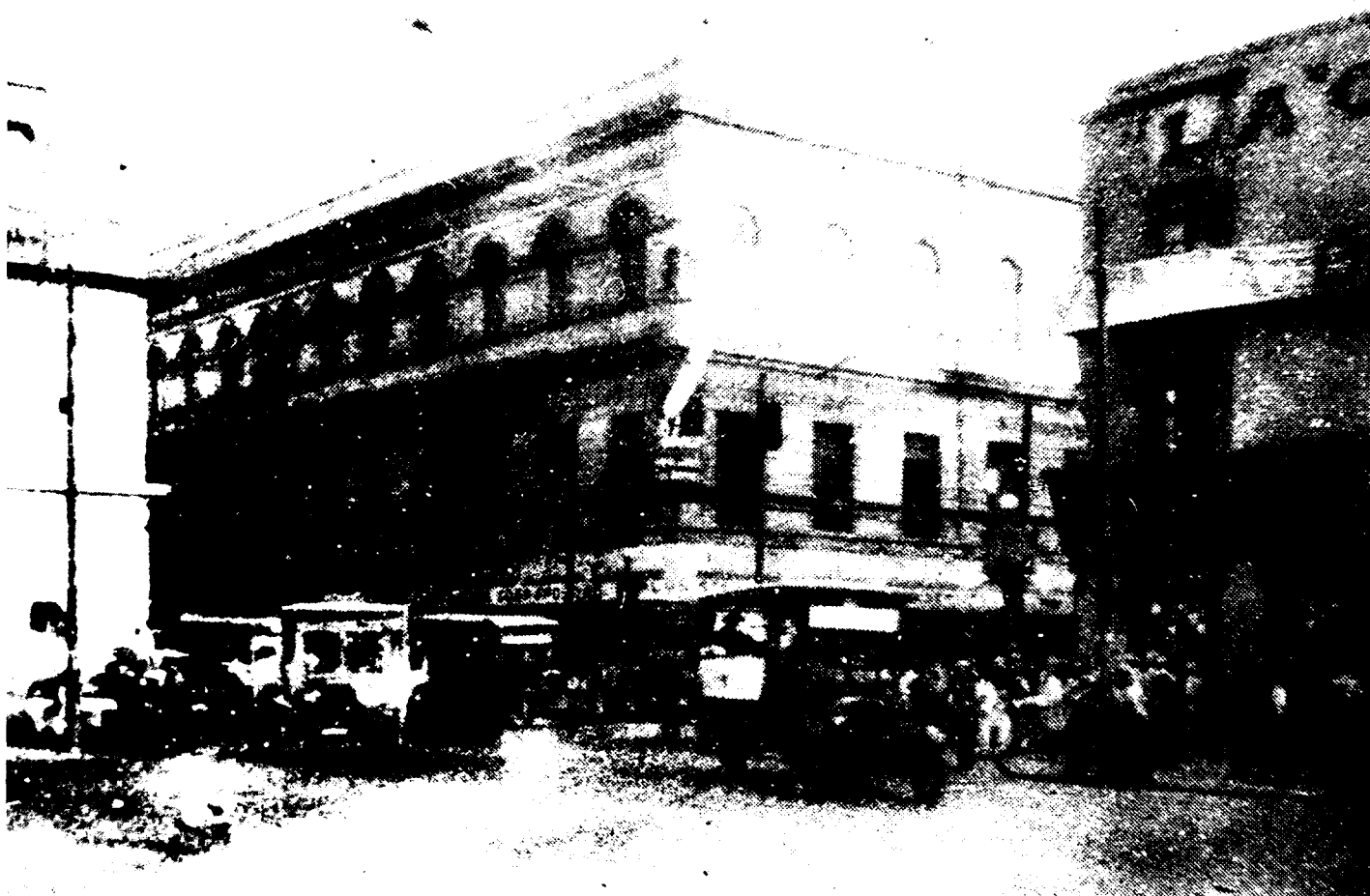
75 Perspectiva del ángulo norponiente del edificio del Mercado del Volador, con fachadas hacia Corregidora y Pino Suárez.
