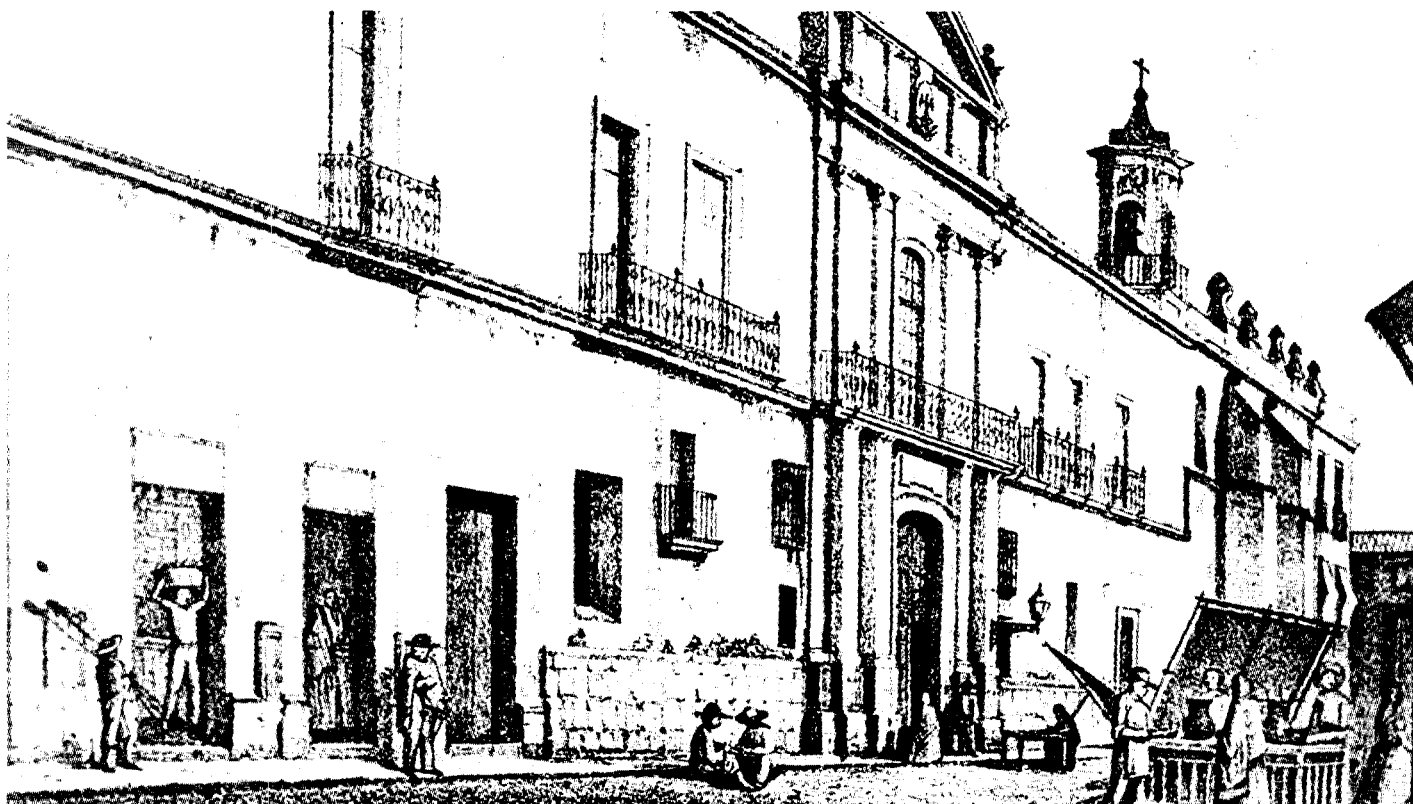
73 Fachada del Edificio de la Real y Pontificia Universidad de México, frente a la Plaza del Volador, derruido en 1910.
