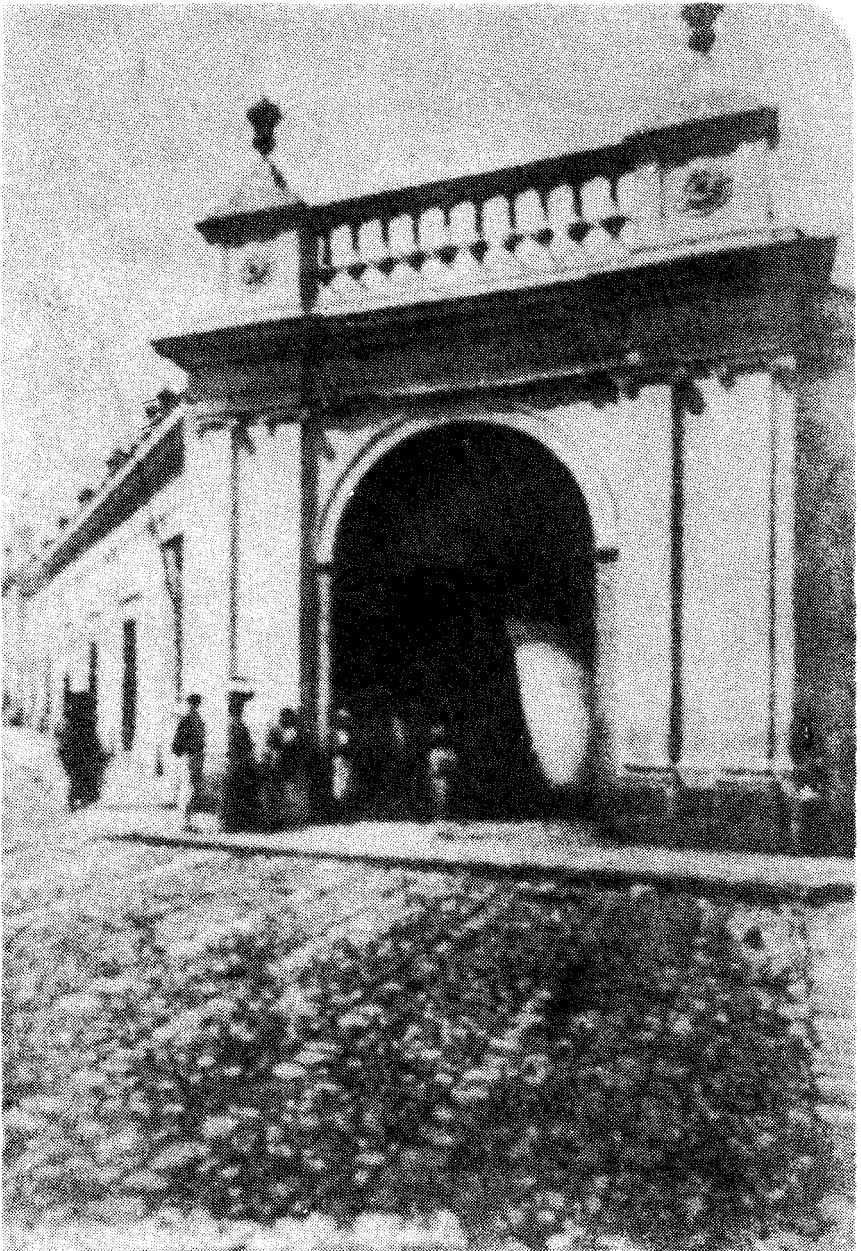
Mercado Central de la Ciudad de Guatemala, en la parte posterior de la Catedral. Con esta estructura existió hasta el terremoto de 1976 que lo destruyó. (Colección Muybridge)
