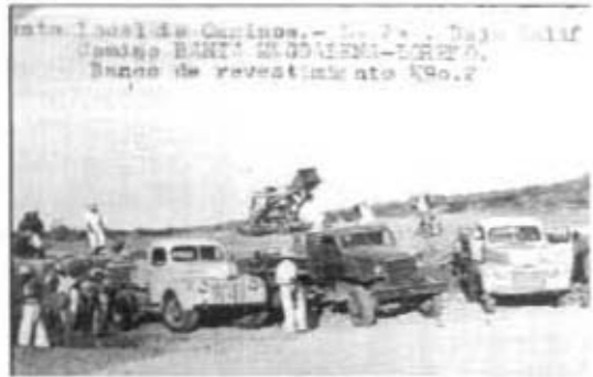
Banco de revestimiento en la construcción del camino Magdalena-Loreto en 1946.
