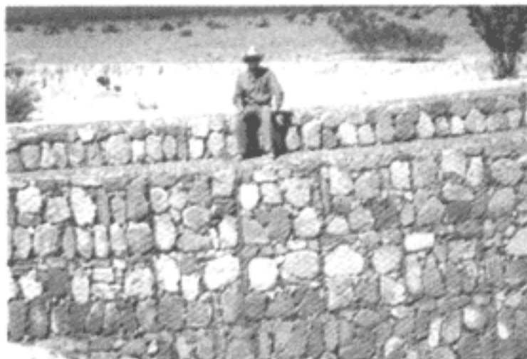
Ilustración 2.3. Presa de gavión de pequeña escala terminada, para contener las escorrentías en temporada de lluvias, Charcos de Risa, Mpio. Francisco I. Madero, Semidesierto de Coahuila
