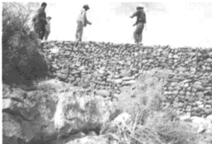
Ilustración 2.2. Proceso de construcción de presa de gavión de pequeña escala, para contener las escorrentías en temporada de lluvias, Charcos de Risa, Mpio. Francisco I. Madero, Semidesierto de Coahuila.
